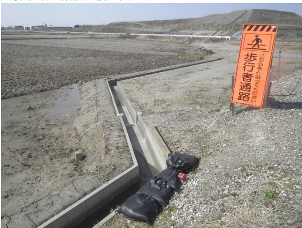
用排水路の機能回復が図られました
